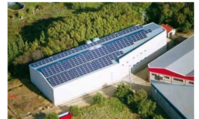
50 kWp – Alquería de Aznar (Alicante)
