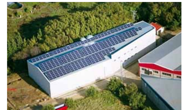
50 kWp – Alquería de Aznar (Alicante)
